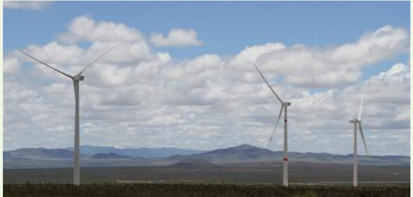
PARQUE EÓLICO "DOMINICA", EN EL GREEN POWER MÉXICO, Las Charcas, San Luis Potosí.
